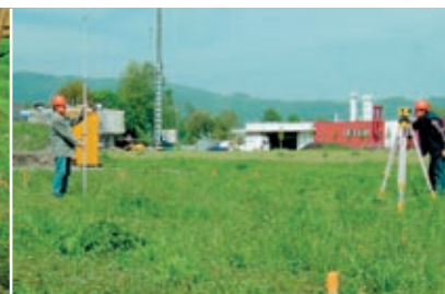
Nivelación de superficies
